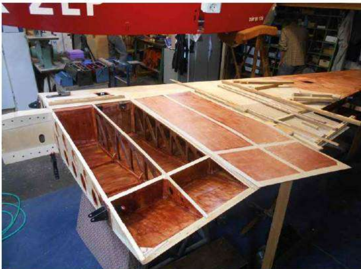
Levé křídlo otočené spodní stranou nahoru je již zkontrolováno, opravené a je uvnitř i prolakované. Zbývá jen uzavřít jeho dutinu překližkovým potahem. Na snímku je vidět zadní stranu hlavního nosníku křídla a zadní pomocný nosník křídla s kováním uchycení do trupu.
